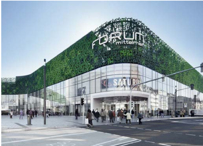
Een onderscheidende, doorlopende plint met transparante overzichtelijke hoeken
